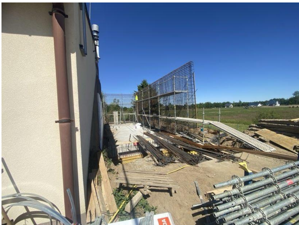
Fot. Wykonanywana modernizacja oczyszczalni ścieków w Nowym Dzikowcu
