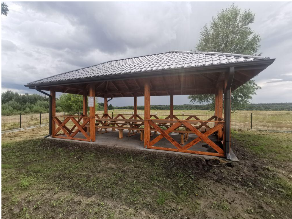
Fot. Rozbudowany plac zabaw w Wilczej Woli
