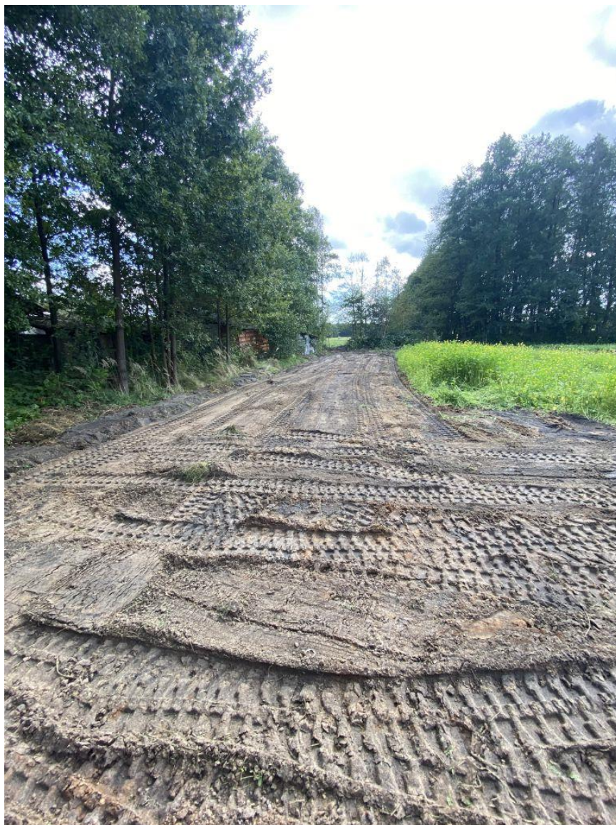
Fot. Wykonanywana kanalizacja sanitarna w miejscowości Wilcza Wola – Pniaki
