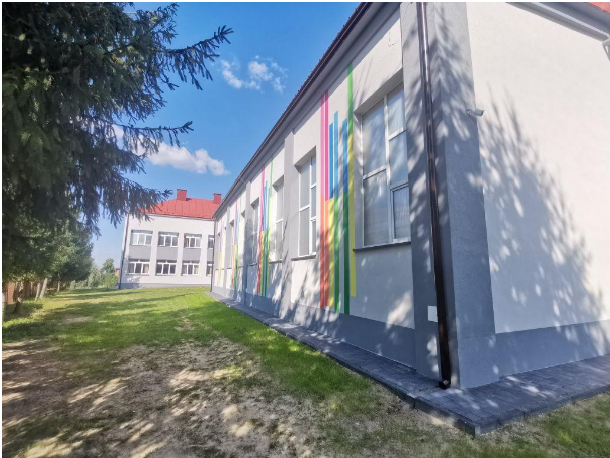
Fot. Wykonane zadanie pn.: „Modernizacja infrastruktury edukacyjnej w miejscowości Lipnica”
