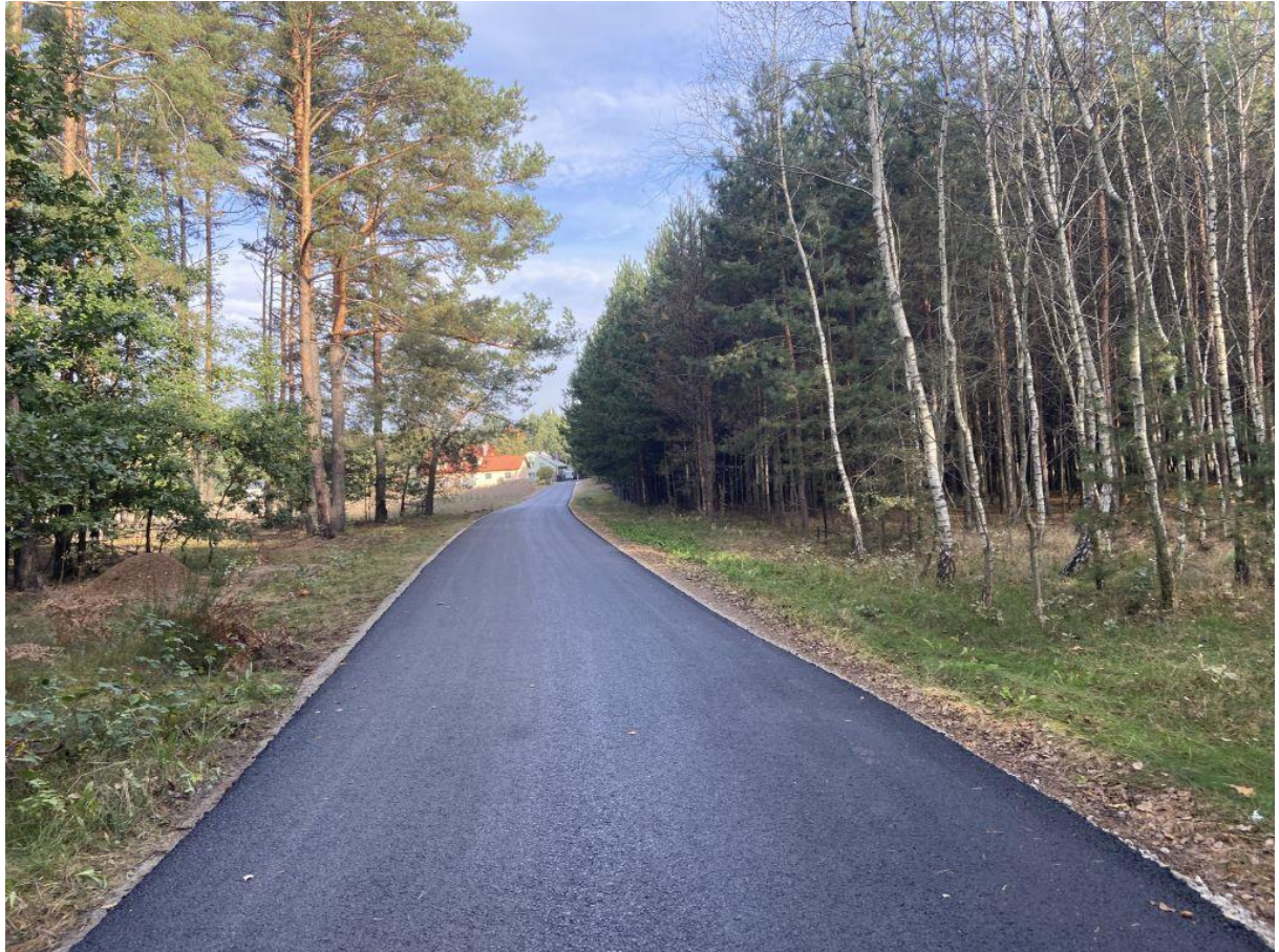
Fot. Wykonana droga w miejscowości Lipnica
