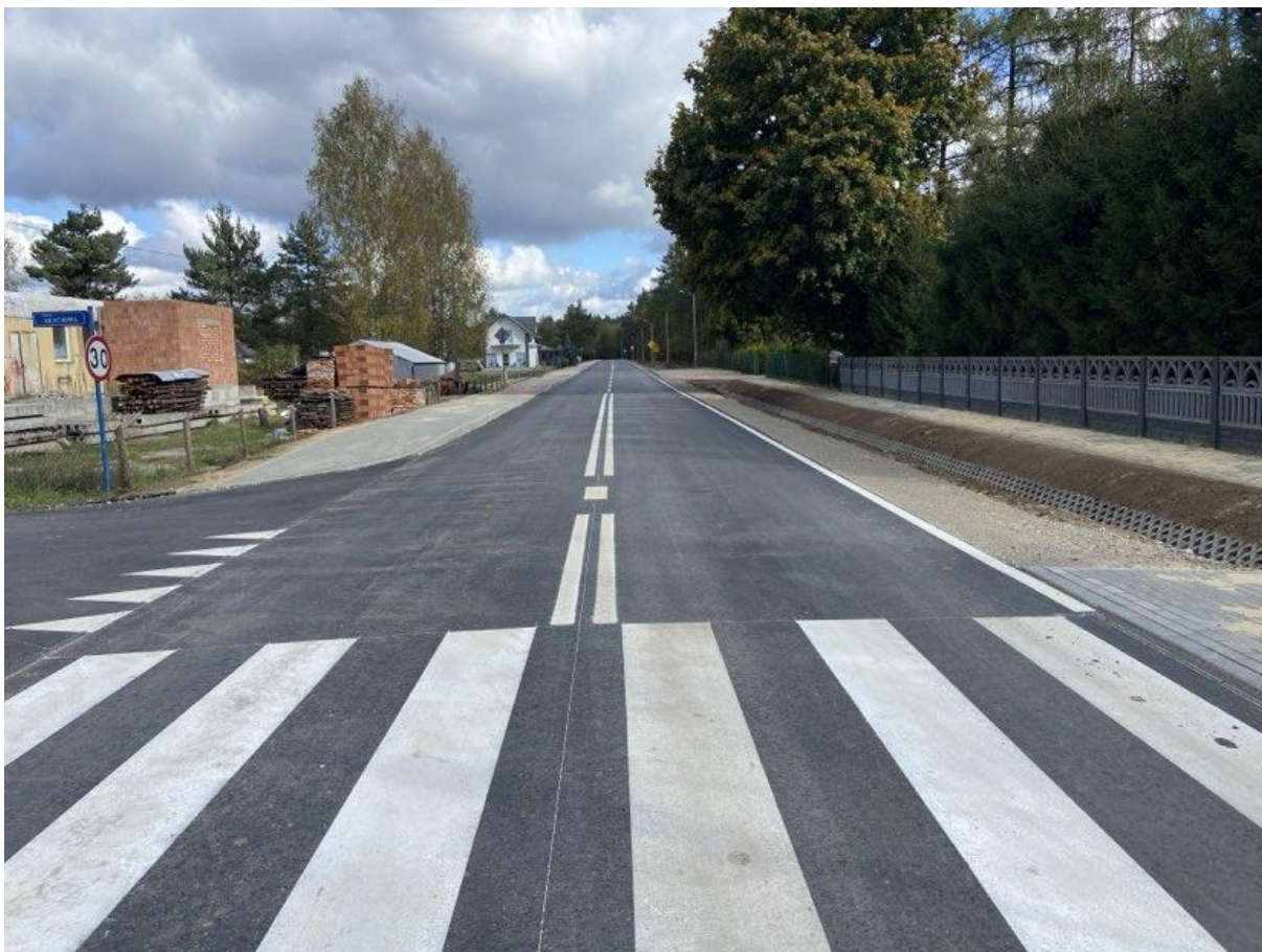
Fot. Wykonana przebudowa drogi powiatowej w miejscowości Wilcza Wola
