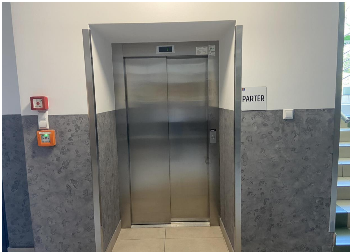
Fot. Wykonana winda w budynku Urzędu Gminy Dzikowiec
