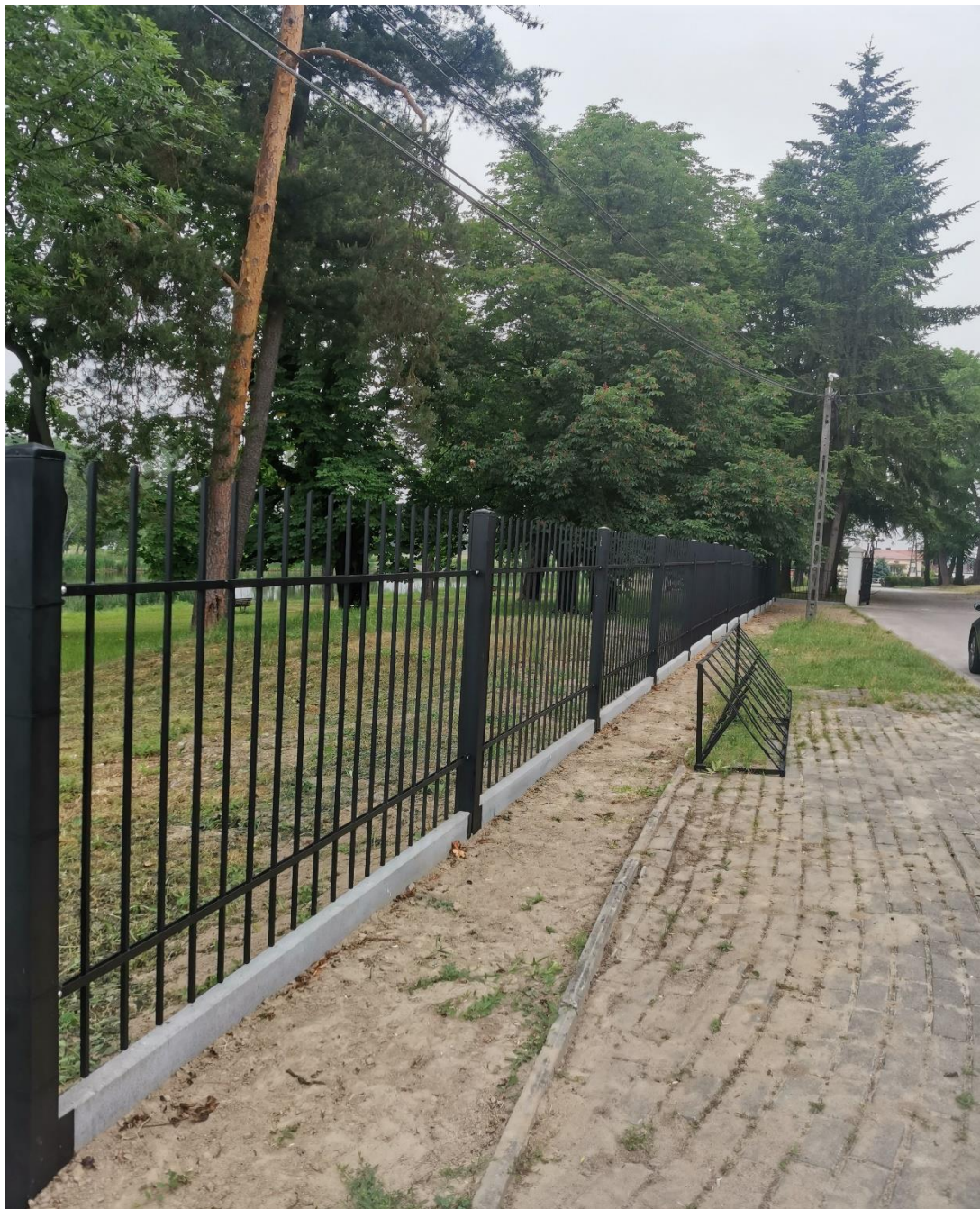
Fot. Modernizacja infrastruktury kulturalnej poprzez rewaloryzację zespołu parkowo – dworskiego w Dzikowcu
