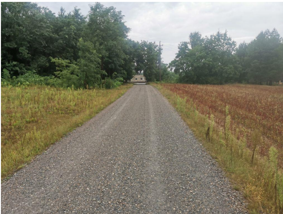
Fot. Wykonana droga dojazdowa do pól w miejscowości Lipnica
