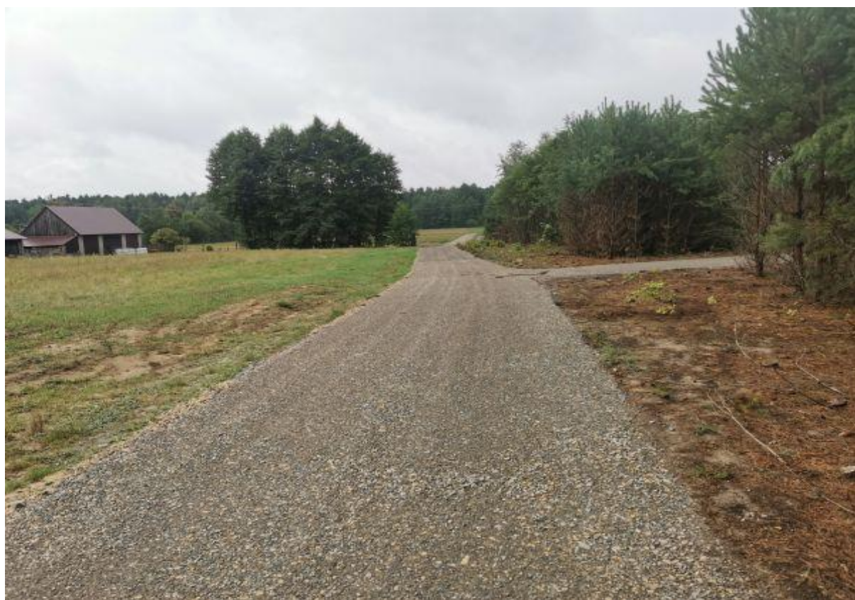
Fot. Wykonana droga dojazdowa do pól w miejscowości Kopicie
